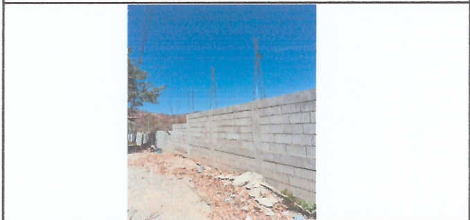
Foto 4: Mejoramiento instalación de malla metálica sobre muro perimetral.
